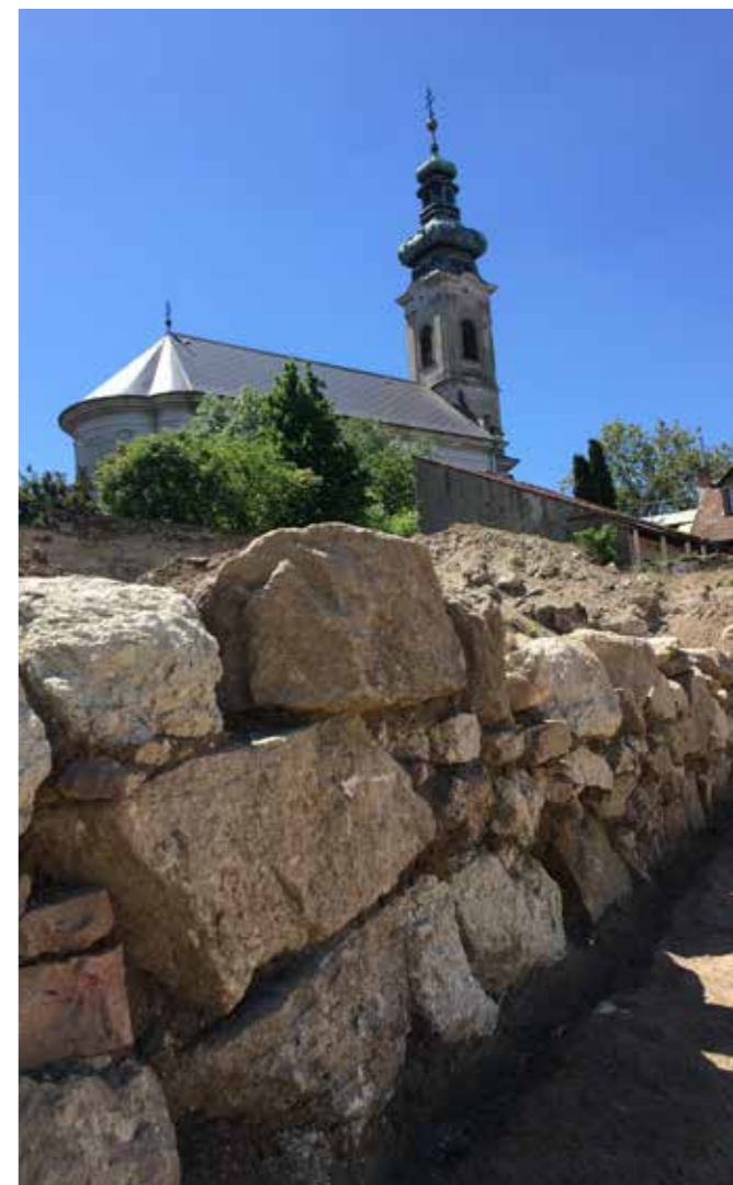
Lakóház falrész felismerhető környezettel
